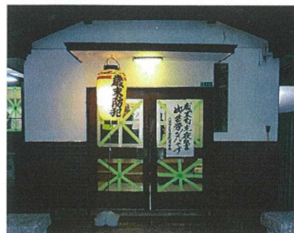
御開公民館玄関先に「歳末防犯」提灯を設置しました。
