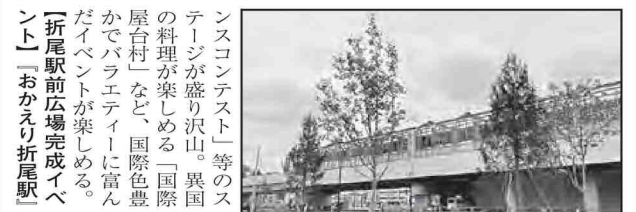
植栽が加わり完成間近な駅前広場
