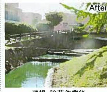
清掃・除草作業後
